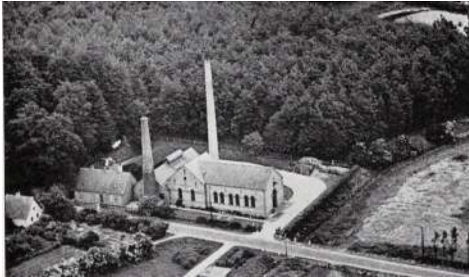
Søndersøværket ved Ballerupvej, som det så ud omkring 1950 før de nuværende bygninger blev bygget. Disse bygninger blev nedrevet i 1960'erne.
